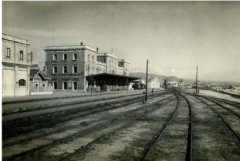
Ilustración 3: Vista general de la estación, lado Barcelona, antes de la electrificación
